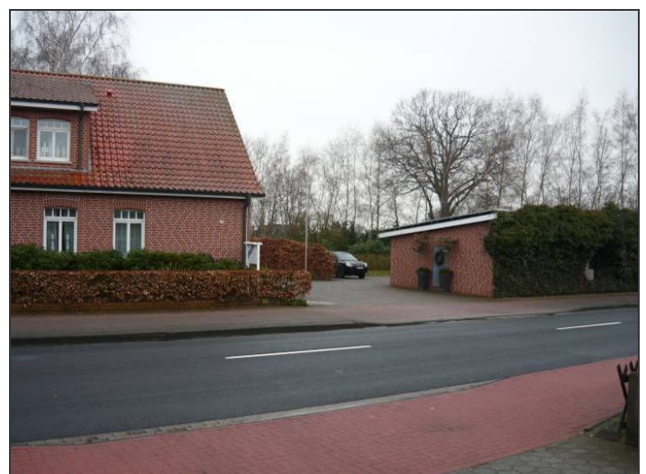
Installation im rechten Gebäude (Garagen)
